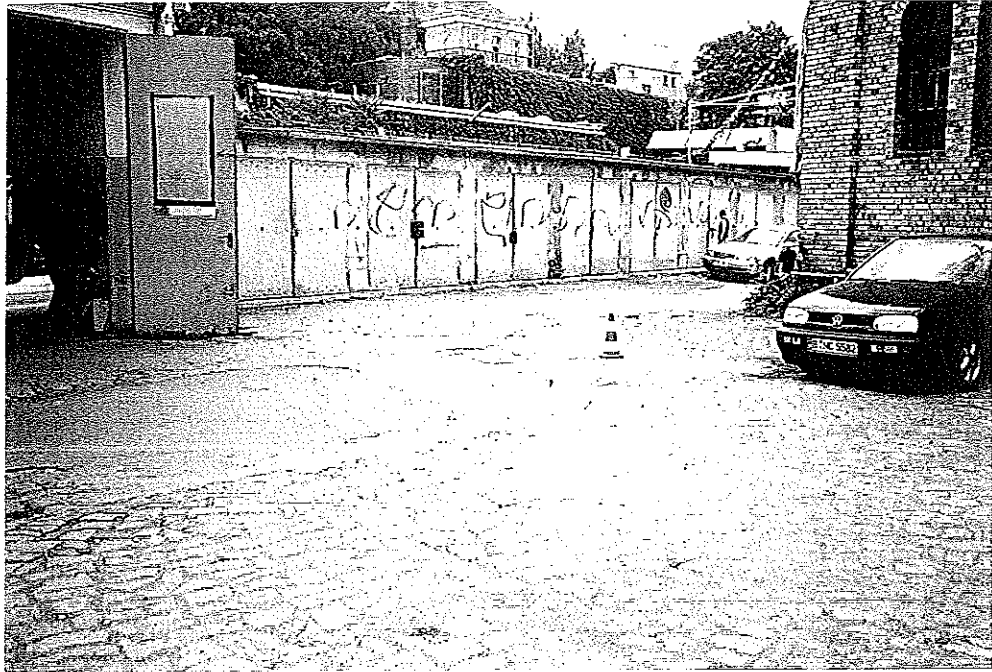
Bild 3: Blick aus südöstlicher Richtung auf den Bohrpunkt der Rammkernsondierung RKS 3 (markiert mit rot-weißem Warnkegel), der neben einem Leichtflüssigkeitsabscheider liegt. Die Sondierung wurde als Rammpegel und Grundwassermeßstelle BR 2 unterflurig ausgebaut und mit einer ovalen Hydrantenkammer abgeschlossen..
