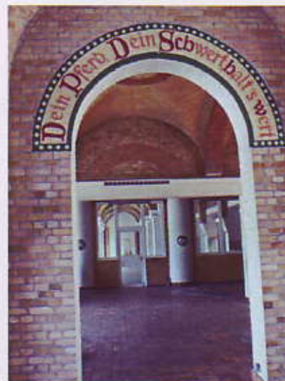
Denkmalgeschützter Bereich Gebäude 14 / 16
