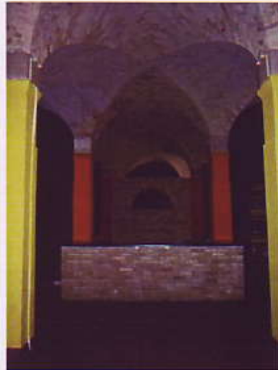
Denkmalgeschützter Bereich Gebäude 7
