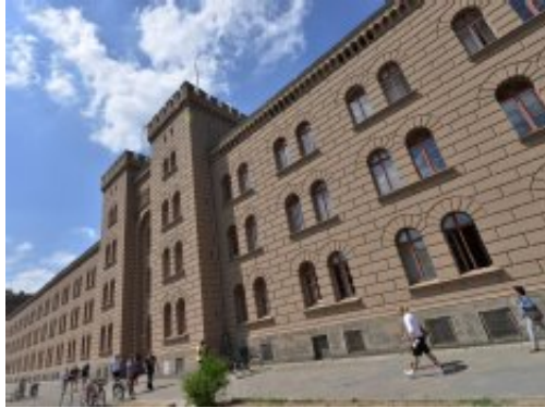
Die ehemalige Garde-Dragoner-Kaserne in Kreuzberg
